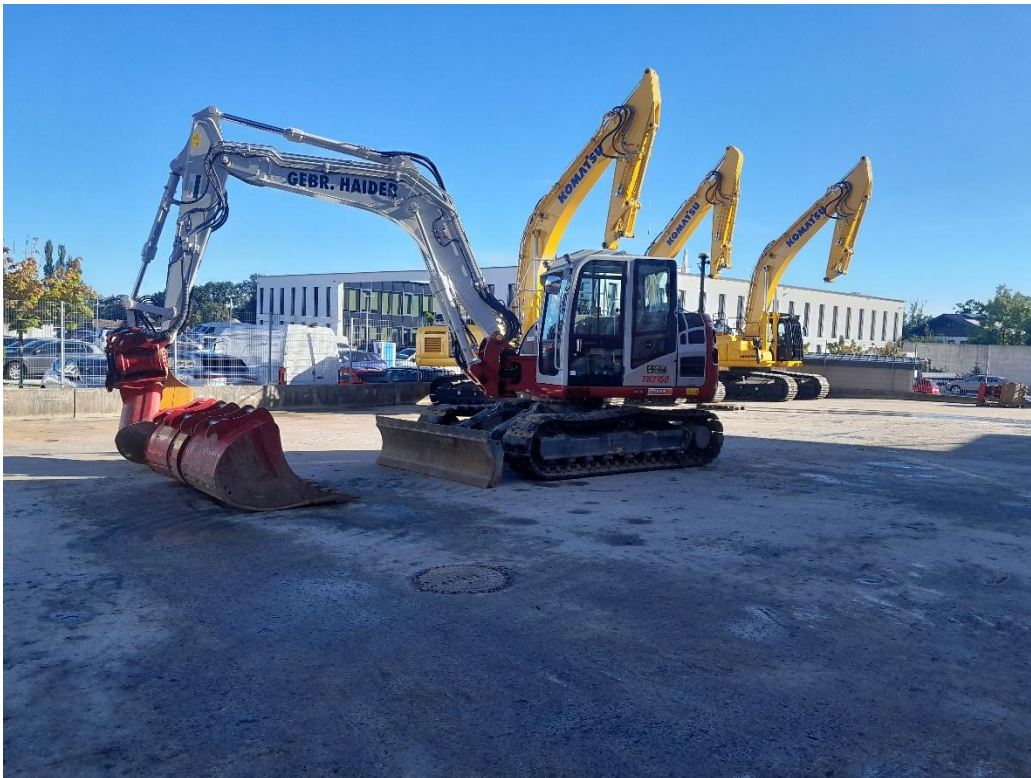
Der Bagger der Gebr. Haider Bauunternehmung ist nun mit der zweiten Topcon GX-90 Maschinensteuerung von Kuhn ausgestattet
