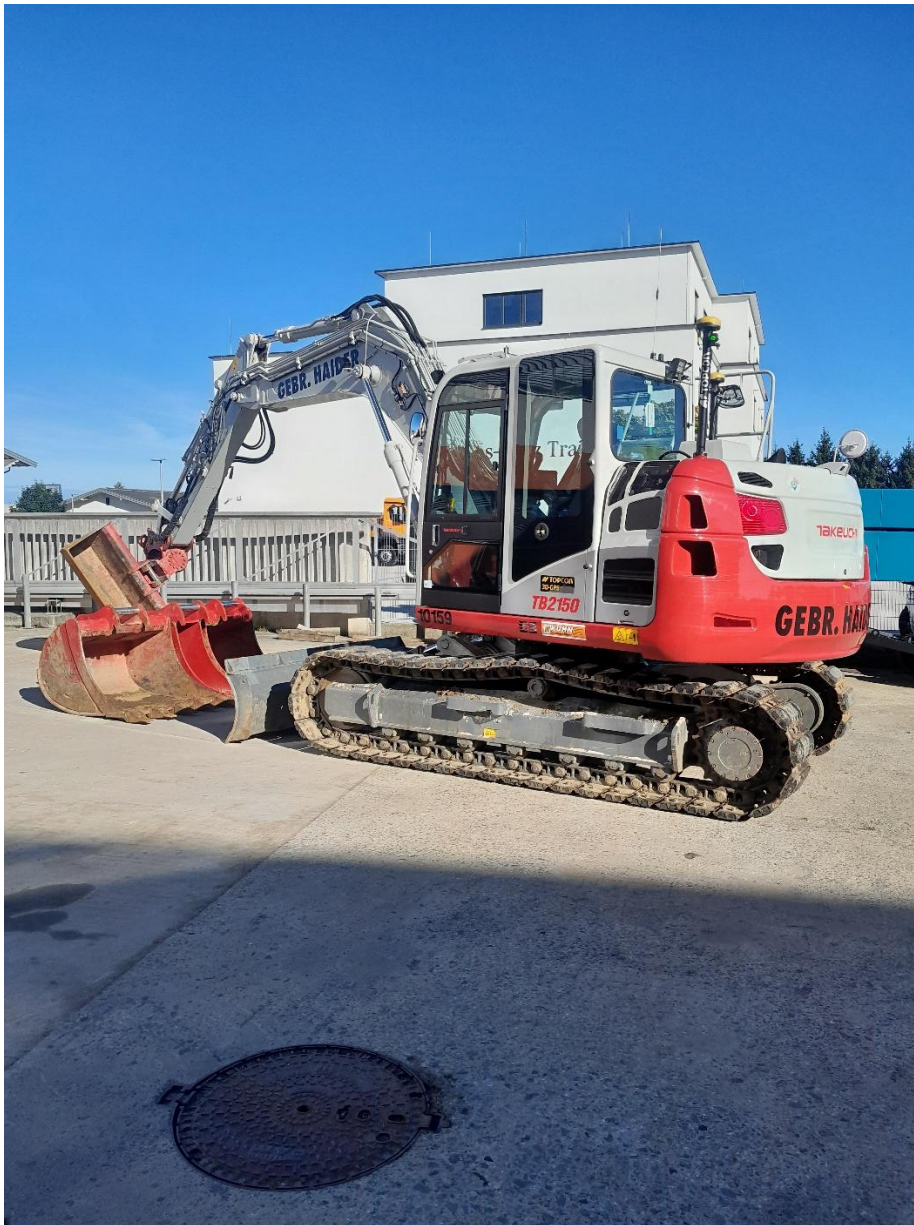
Detailaufnahme des Baggers mit montierten Topcon-Antennen und Steuerungseinheit
