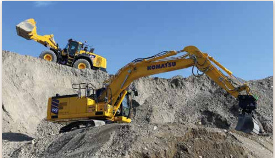
Zwei Maschinen im Mittelpunkt: Der Komatsu PC220LCi-12 und der WA475-11Eo im Roadshow-Einsatz.
