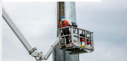
Bei Arbeiten an Telekommunikationsmasten sowie Übertragungs- und Stromleitungen sind besondere Sicherheitsanforderungen zu beachten. Freileitungen bspw. müssen während der Arbeit abgeschaltet sein, falls keine hochisolierte Hubarbeitsbühne verwendet wird. Bei stromführenden Leitungen bis 1000 V ist man mit einem doppelt isolierten Korb bereits besten geschützt.
